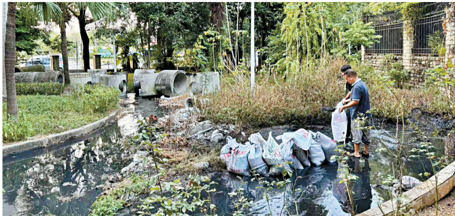
■11日下午,清淤工作人员正在清理现场的淤泥和污水。
