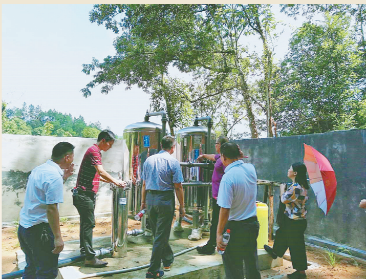
自来水设备正在安装中
